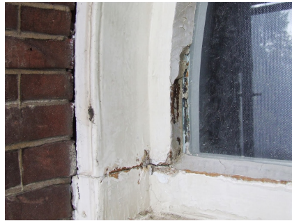
Vervangen stopverf
