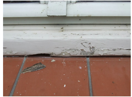
Knoest verwijderen + onderzijde onderdorpel herstellen
