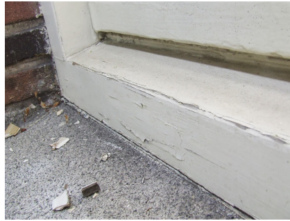
Scherpe kanten + kitnaad verwijderen + scheurvorming herstellen
