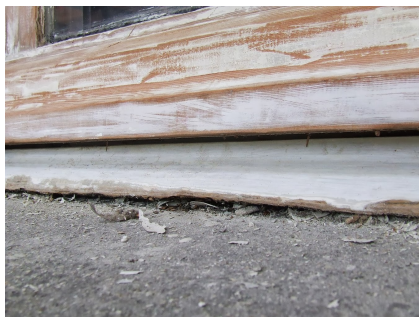
Onderzijde open halen met de lamineerzaag, vervolgens afdichten met de renobond
