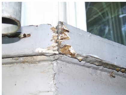
Vervangen (dit gezien de omvang van de aantasting)
