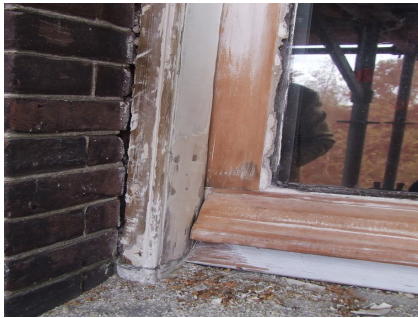
Ondeugdelijke stopverfnaden vervangen
