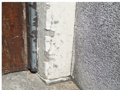
Mechanische beschadiging
