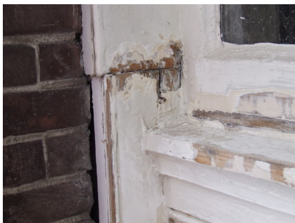
Aanbevolen voor de neggekanten: deze open te maken c.q. te houden ter bevordering van de ventilatie
