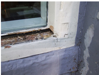
Glaslat dient vervangen te worden. Verder zal de onderdorpel gelamineerd worden
